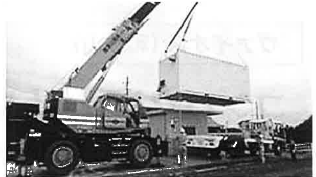
縦に配置した場合の外観(左)、コンテナ納品のように。据付後、配管接続や試運転、制御設定等は2日間で可能(右)
