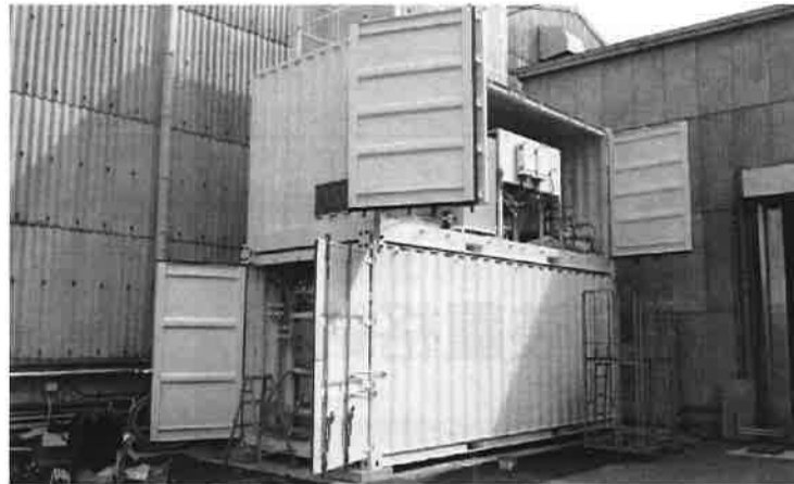
縦に配置した場合の外観(左)、コンテナ納品のように。据付後、配管接続や試運転、制御設定等は2日間で可能(右)
