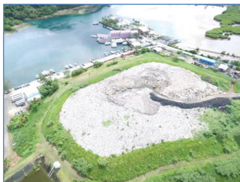
パラオの埋め立て処分場
